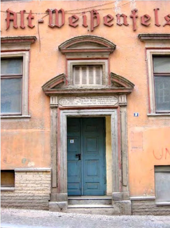
Aufwendig gestaltetes Portal mit Oberlicht aus dem Jahr 1697
