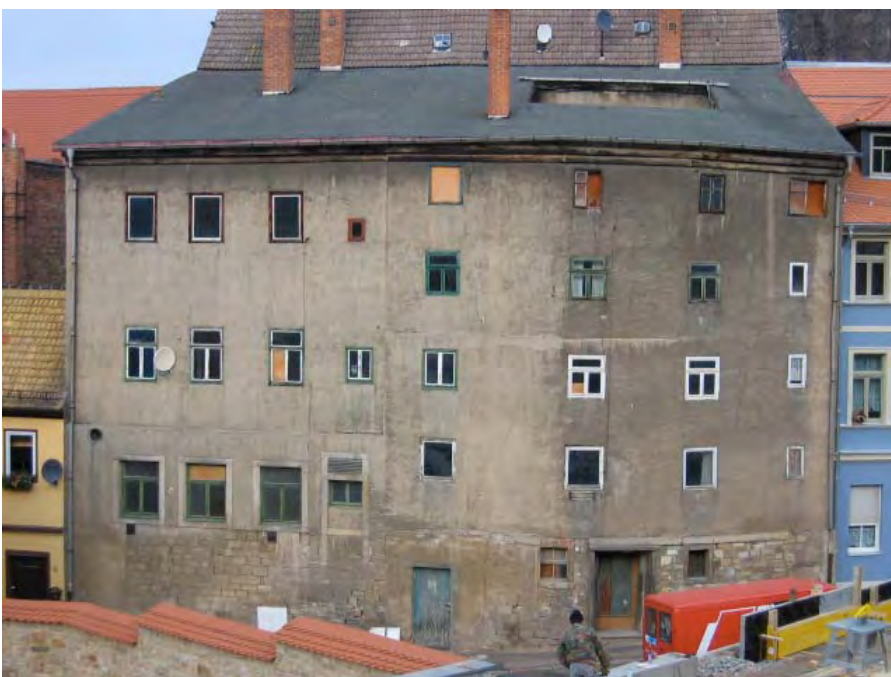
Rückwärtige Fassadenansicht Große Burgstraße 19 in der Kleinen Burgstraße. Im Dach ist der Ausschnitt des Innen- hofes zu erkennen.
