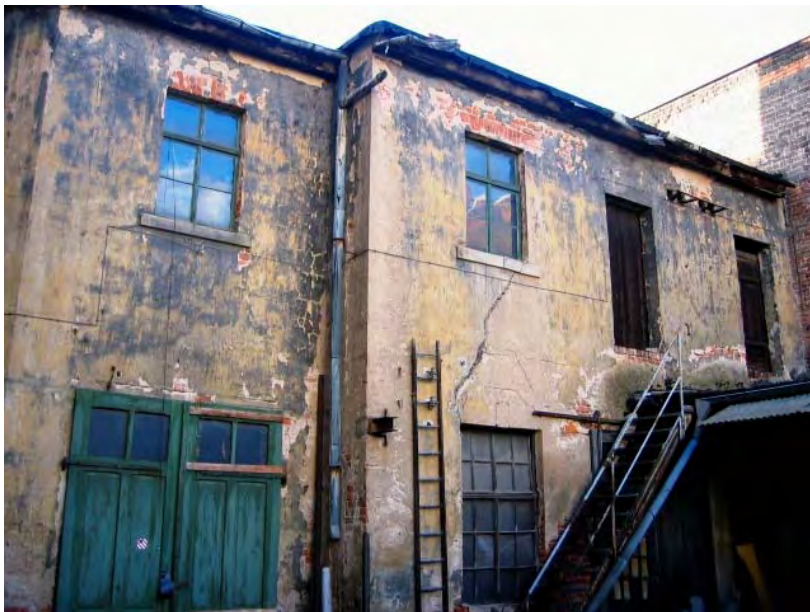
Seitenansicht des im Hof befindlichen Nebengebäudes aus östlicher Richtung
