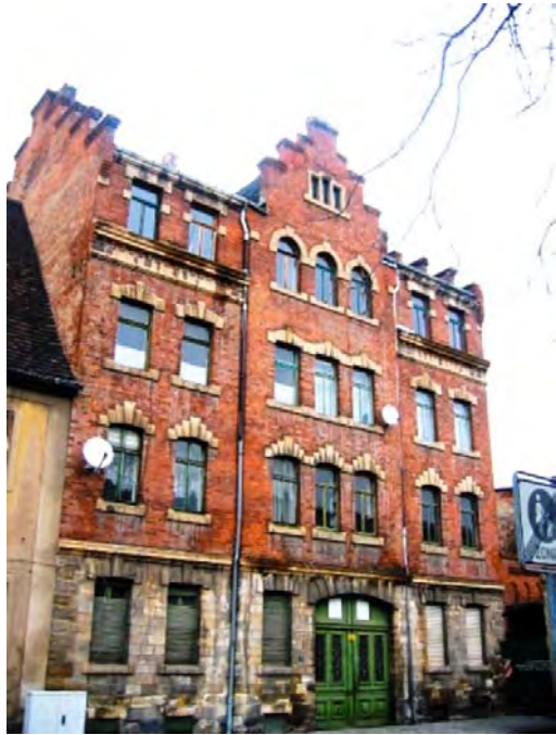
Blick aus südlicher Richtung. Vorderansicht des Wohngebäudes Große Kalandstraße 27
