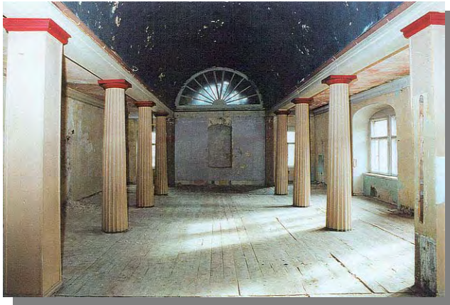
Raumansicht in Richtung Osten 2. OG, Westflügel
