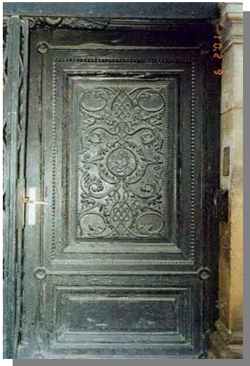
Ansicht eines Türblattes des Eingangsportals, Nordflügel
