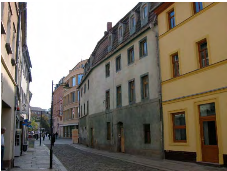
Ansicht des Gebäudes aus der Kleinen Kalandstraße
