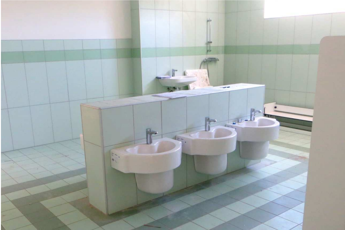
In den Sanitärräumen müssen Handwerker nur noch Restarbeiten vornehmen.
