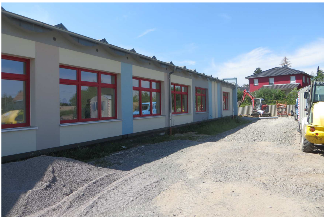
Die Außenanlage der neuen Kita in Tagewerben muss noch hergerichtet werden.
