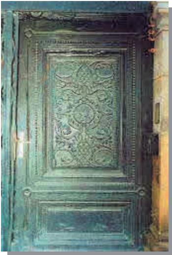
Ansicht eines Türblattes des Eingangs- portals, Nordflügel
