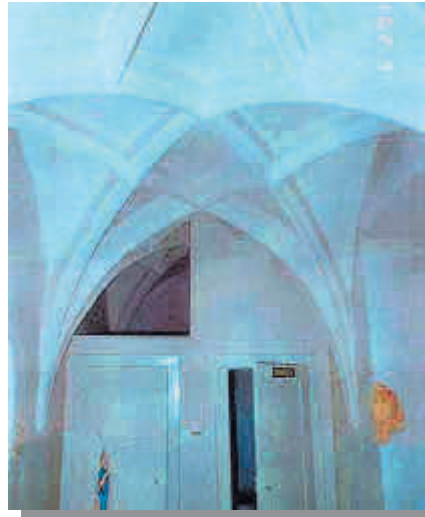
Raumansicht Erdgeschoss, Ostflügel
