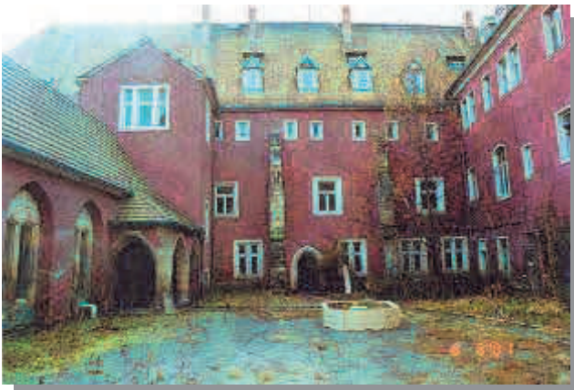
Innenhof und Ansicht des westlichen Klausurgebäudes
